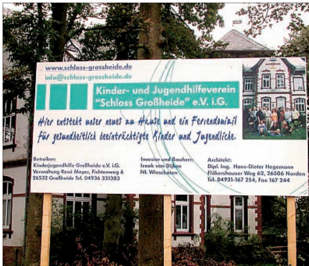
Für jedermann gut sichtbar, steht am Schloss Großheide mittlerweile ein großes Bauschild, das auf die Renovierung und Nutzungsänderung hinweist. FOTO: HEIN
